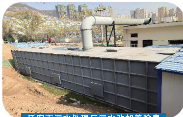
延安市污水处理厂污水池加盖除臭
