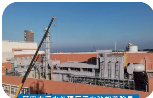
延安市污水处理厂污水池加盖除臭
